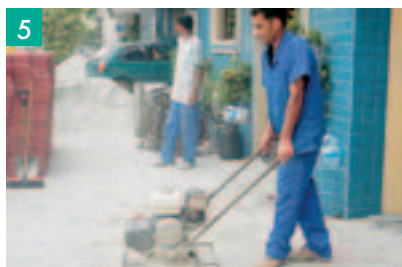
5 Compactação inicial, revisão, ajustes, espalhamento de areia, rejuntamento e compactação final.
