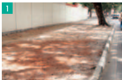
1 Nivelamento e compactação do subleito (terreno).
