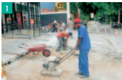
1 Nivelamento e compactação do subleito (terreno).
