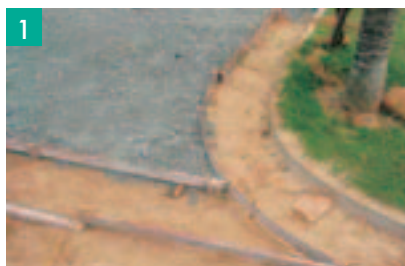
1 Nivelamento e compactação do subleito, colocação de brita, instalação das fôrmas e telas de aço.
