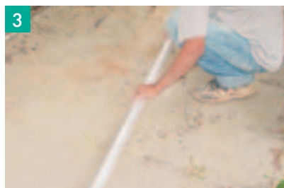
3 Espalhamento e nivelamento de areia de assentamento (ou pó de brita).
