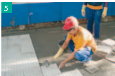
5 Assentamento das placas.
