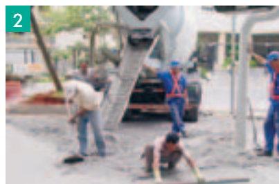
2 Lançamento, espalhamento e nivelamento (sarrafeamento) do concreto.
