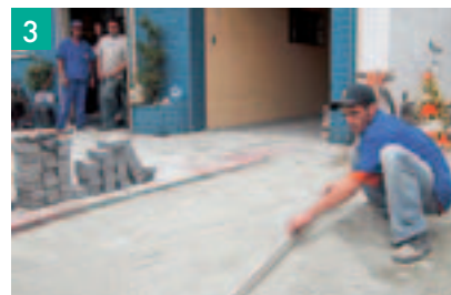
3 Espalhamento e nivelamento (sarrafeamento) da areia de assentamento.
