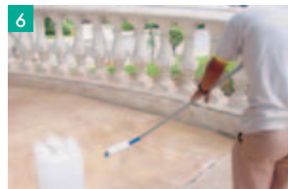
6 Execução de juntas de controle, lavagem, aplicação de resinas e liberação ao tráfego.
