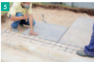
5 Execução de cortes, ajustes e alinhamento.
