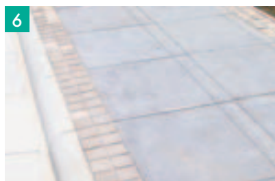
6 Limpeza e liberação ao tráfego.
