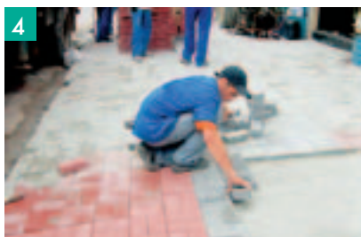
4 Colocação das peças de concreto, alinhamento, cortes e ajustes.
