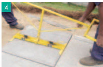
4 Colocação das placas de concreto com saca-placas.
