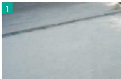
1 Nivelação e compactação do subleito e execução da base de concreto magro.
