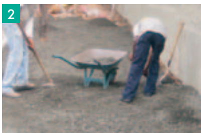
2 Instalação das contenções laterais, nivelamento e compactação da base.
